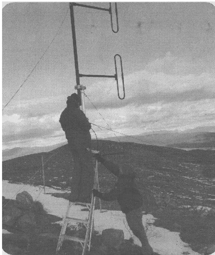
Vern Marshal and Adam MacCannell install a YARA antenna at the VOR/NavCan site. Vern Marshal et Adam MacCannell installent une antenne pour la YARA au site VOR/NavCan.
